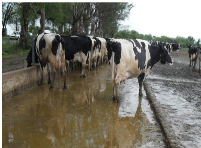
Figura 38. Piso de hormigón ancho, pero sin buen drenaje.
