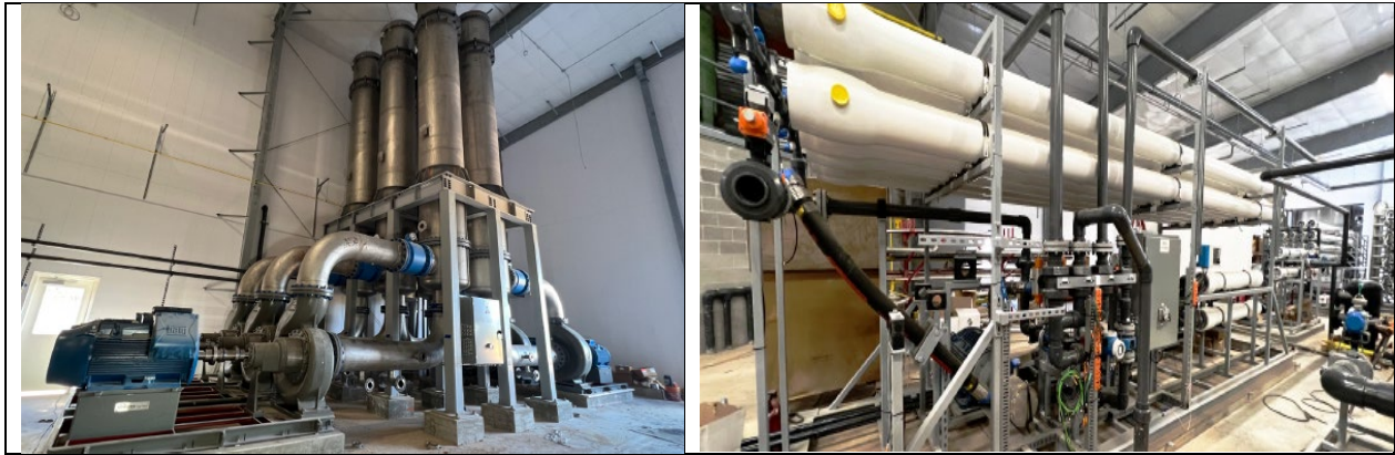
Flotación de aire para separar líquidos de sólidos. Tratamiento de aguas casi potable. Ultrafiltración. Super filtrado con ósmosis inversa.
