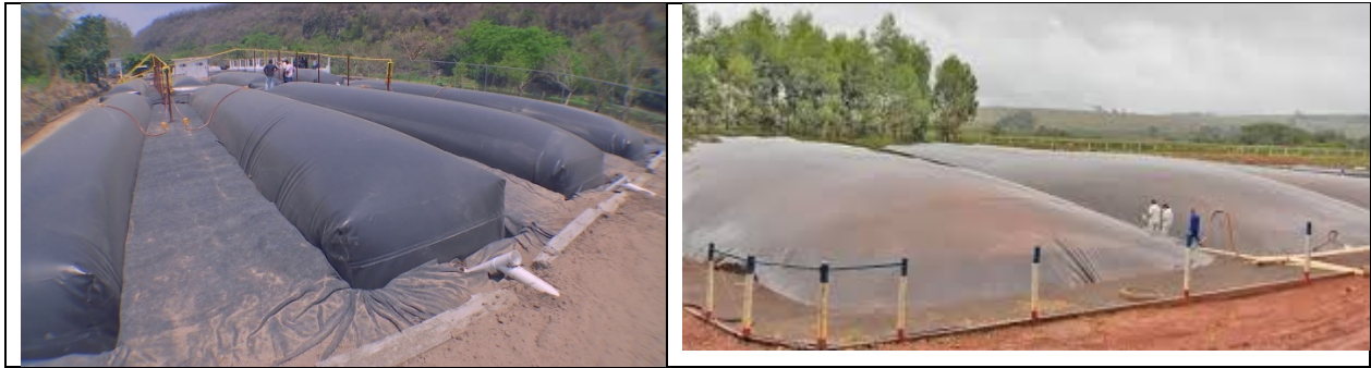
Aireador de laguna abierta. Biorreactores en Brasil. Biogás en Veracruz, México. Otras lagunas anaeróbicas para capturar gas metano producido.
